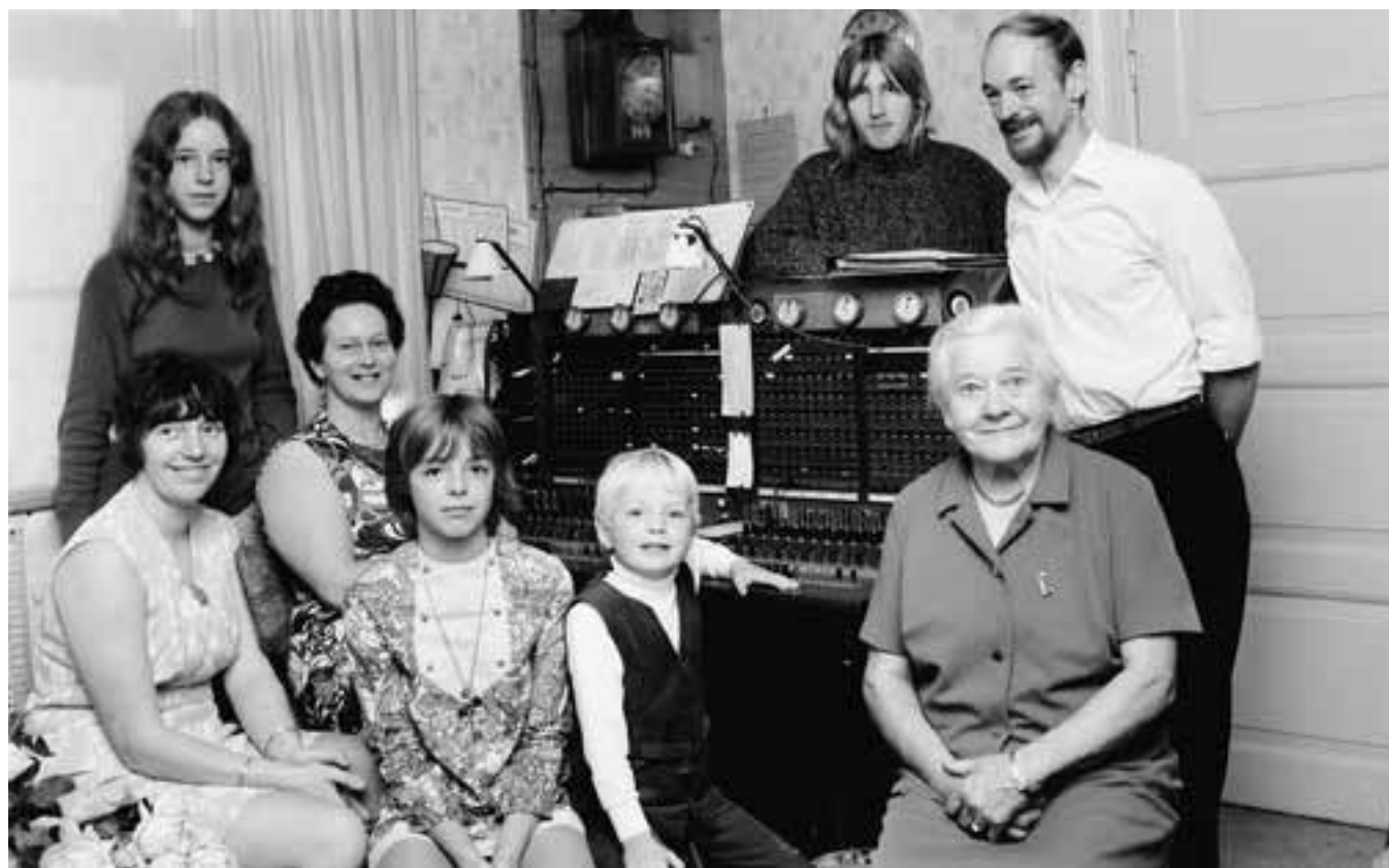
Centralen i Rø automatiseres i september 1972.
