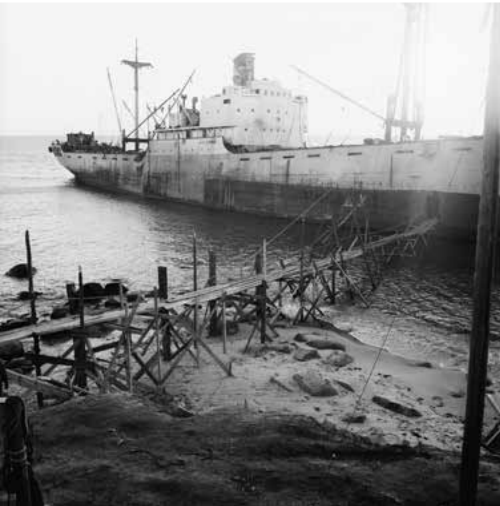
En interimistisk gangbro var besætningens forbindelse med land.
